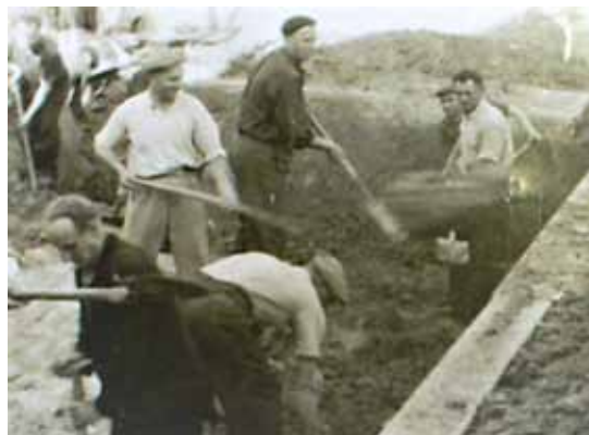
Prace przy fundamentach nowego skrzydła szkolnego
